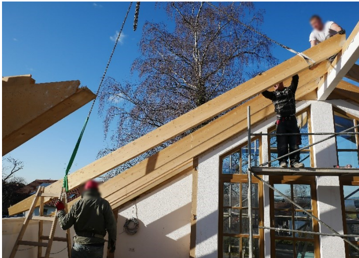
Abbildung 85: Montage der Dachsparren (eigene Darstellung)
