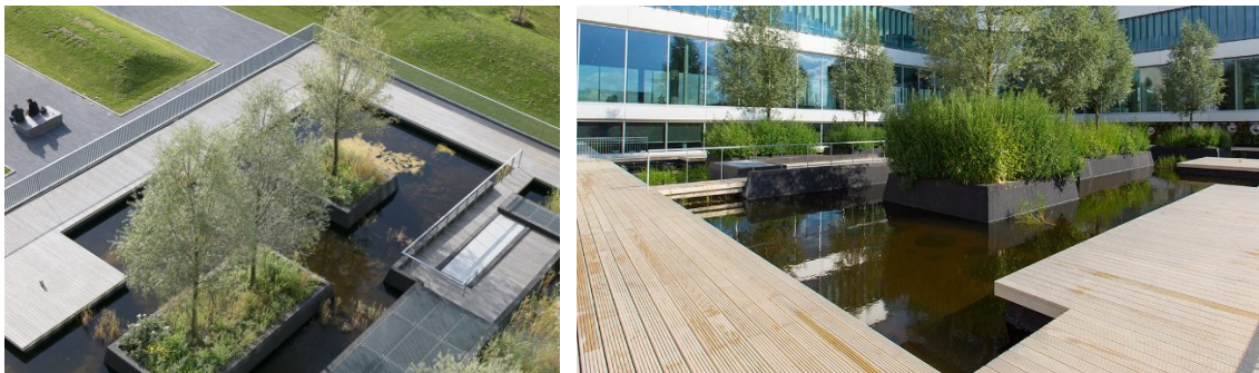
Abbildung 39: Pflanzenkläranlage im Rathaus von Venlo (Foto links: Stijn Poelstra, Foto rechts: Gemeinde Venlo)
