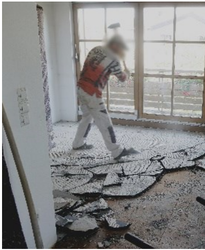
Abbildung 88: Zertrümmern des Gussasphaltestrichs (eigene Darstellung)
