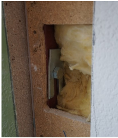
Abbildung 97: Verschraubung Wand/Wand (eigene Darstellung)
