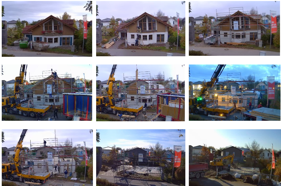
Abbildung 73: Fotografische Dokumentation des Abbaus des Schwörerhauses in Poing (eigene Darstellung)
