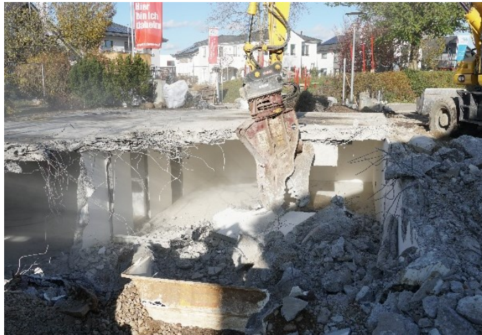
Abbildung 89: Abbruch der Kellerdecke (eigene Darstellung)
