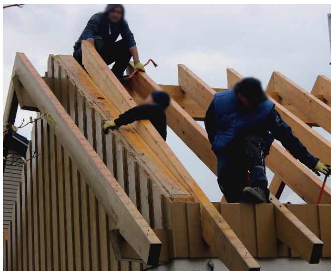
Abbildung 83: Demontage der Dachsparren (eigene Darstellung)
