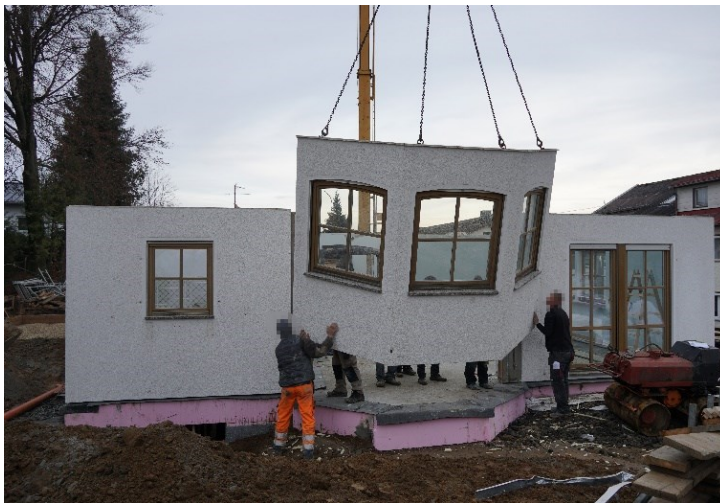
Abbildung 79: Aufbau der Wandelemente (eigene Darstellung)
