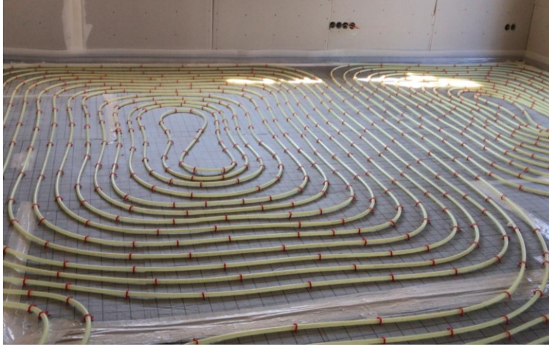
Abbildung 91: Verlegen der Tackerplatten mit integrierter Fußbodenheizung (eigene Darstellung)
