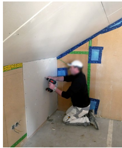
Abbildung 80: Anbringen der Gipskartonverkleidung (eigene Darstellung)
