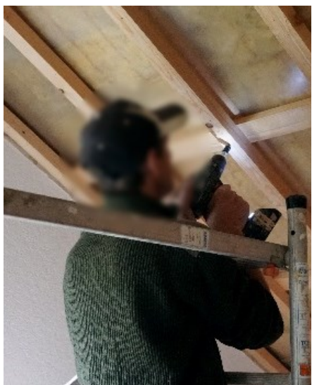
Abbildung 82: Abschrauben der Konterlattung und Lattung (eigene Darstellung)
