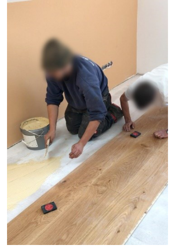
Abbildung 92: Verlegung des Parketts (eigene Darstellung)
